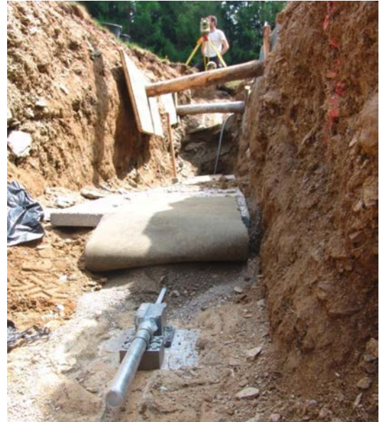
Abb. 10: Faseroptischer Sensor beim Einbau
